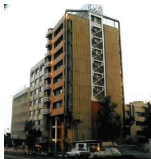
ساختمان اداری معزی
