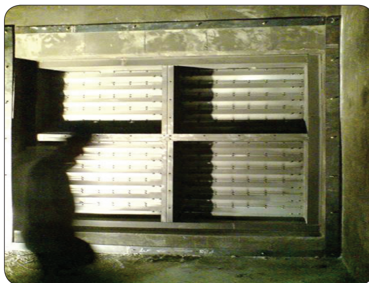
سیستم کنترل آلودگی گاز خروجی با شبکه کاتالیستی - تونل توجید
